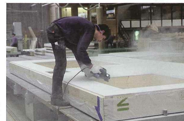
Abschließend wird nochmal manuell nachgearbeitet.
