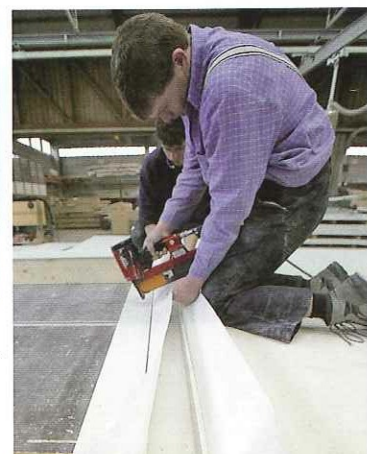
Dämmung wird von Hand eingebracht.
