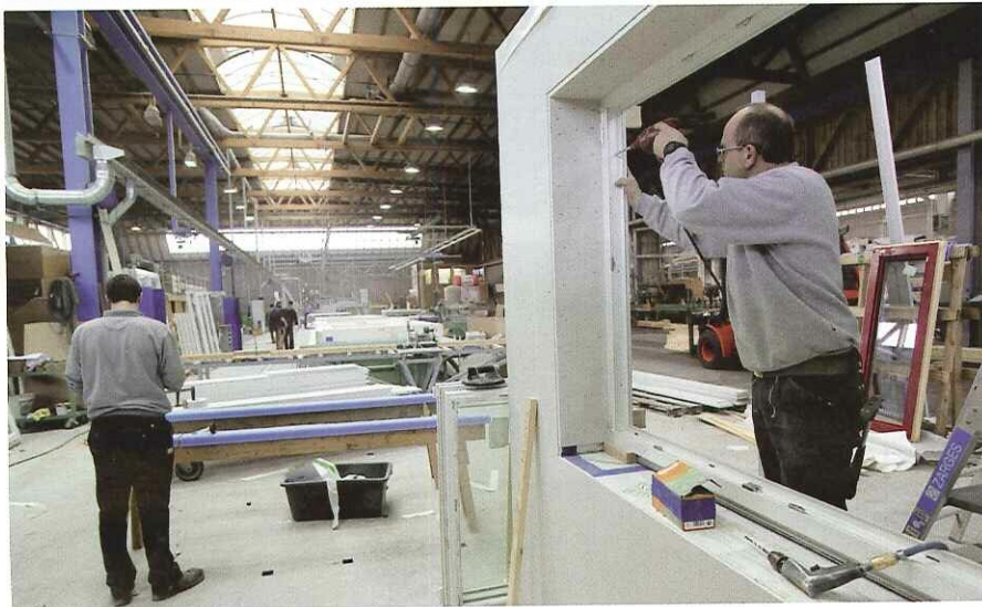
Das ausführende Holzbauunternehmen verfügt über eine eigene Fensterfertigung, so dass in die halbfertigen Wandelemente gleich die Fenster eingebaut werden konnten.
