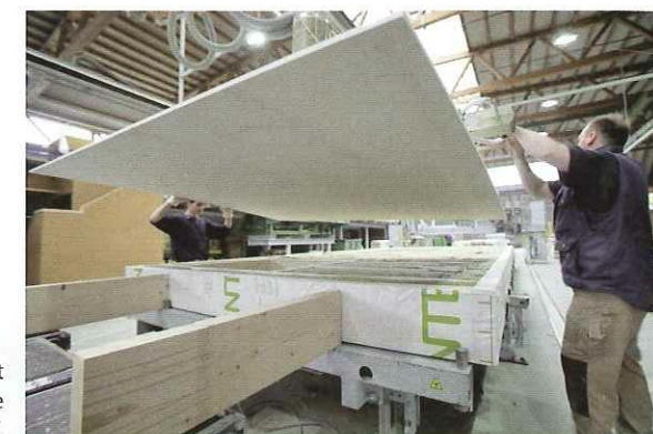
Maschinenunterstützt bringen Mitarbeiter die Beplankung auf.
